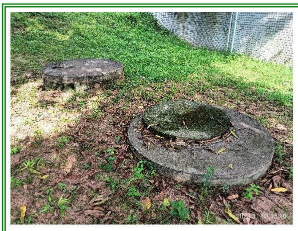
รูปที่ 3-20 บ่อเกรอะบริเวณอาคารสำนักงาน
