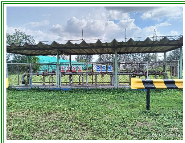
รูปที่ 3-11 ท่อส่งก๊าซธรรมชาติ เพื่อใช้เป็นเชื้อเพลิงสำหรับเตาอบเหล็กและกระบวนการรีดเหล็ก
