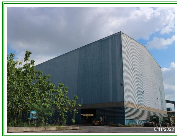
รูปที่ 3-15 อาคารแบบปิด เพื่อป้องกันเสียงและลดเสียงดังออกสู่ภายนอก
