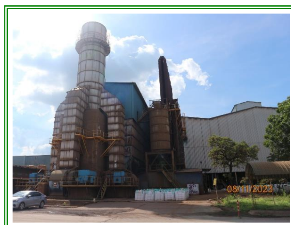
รูปที่ 3-3 ระบบดักฝุ่นแบบ Fume Plant
